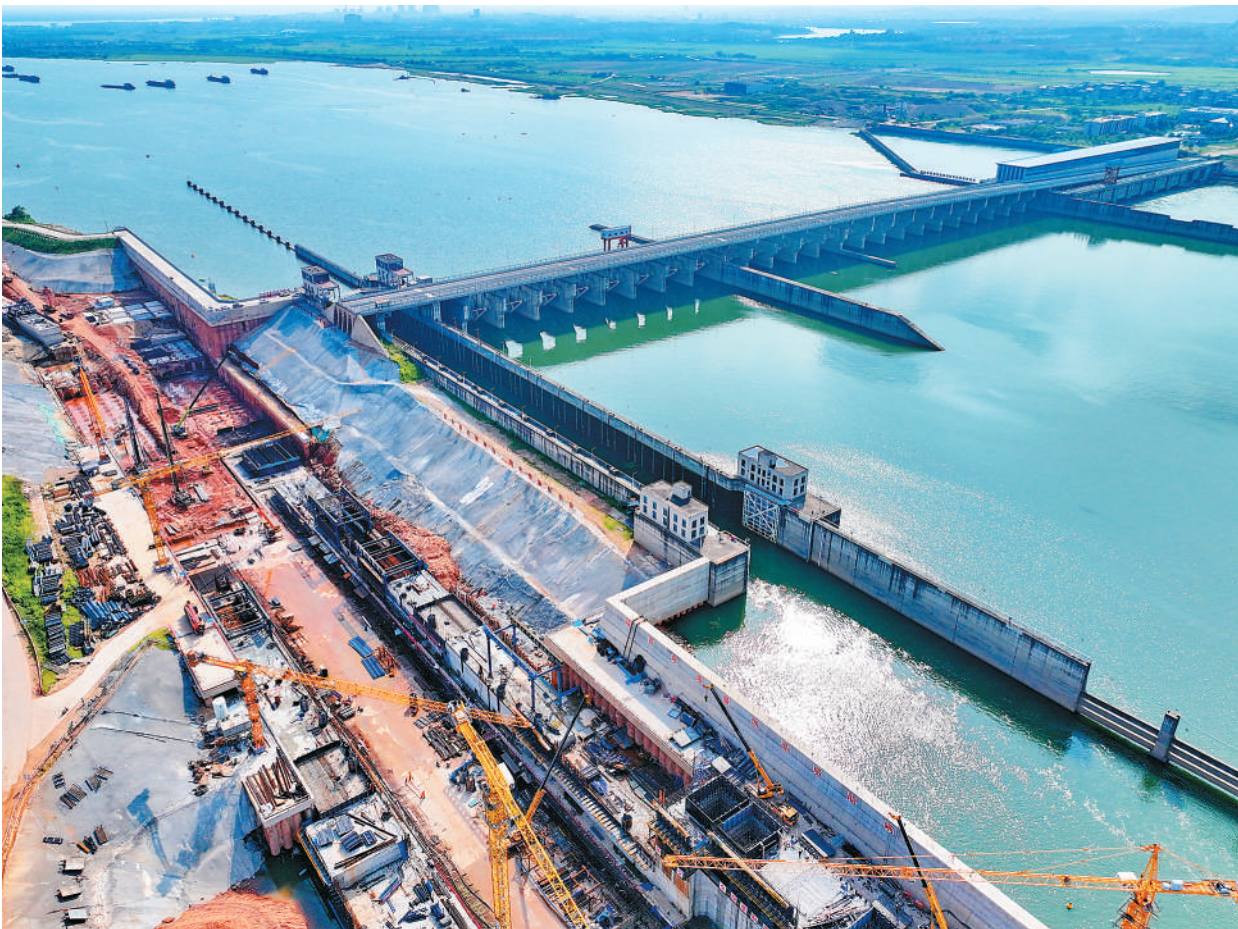
位于江西省丰城市剑南街道的赣江龙头山枢纽二线船闸项目，是赣江高等级航道建设的关键性工程。船闸等级为Ⅱ级，设计年单向通过能力为3753万吨，项目建成后，将进一步提升赣江高等级航道服务能力，助力赣江内河航运稳步发展。图为船闸建设现场。 朱海鹏摄（人民视觉）
