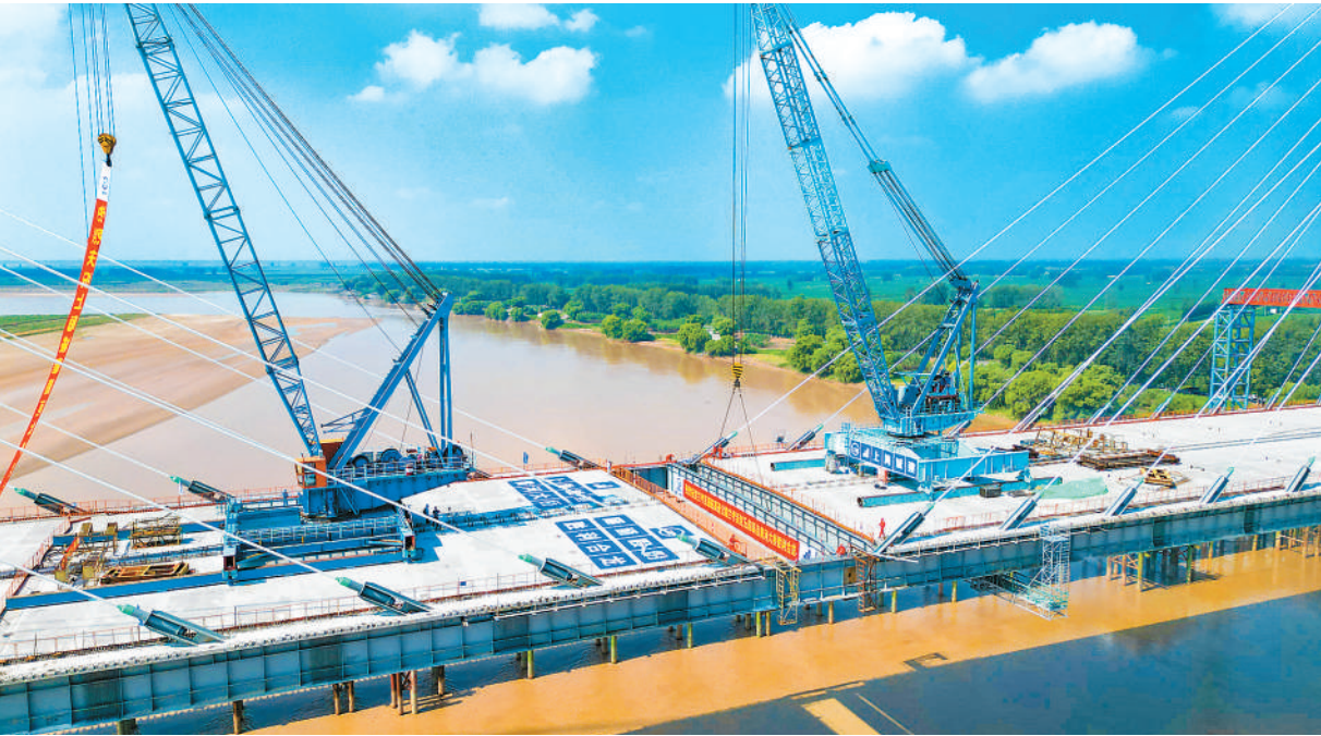
近日，河南境内兰原高速兰考至封丘段黄河特大桥主桥完成最后一根横梁吊装，提前一个月实现合龙，项目建设取得重要进展。据悉，兰原高速兰考至封丘段项目全长30.263公里，设计时速120公里。建成后，将形成平行于连霍高速的东西向大通道，对助推中原城市群发展、促进黄河流域生态保护和高质量发展具有重要意义。 图为兰原高速黄河特大桥主桥合龙现场。 聂冬晗摄（人民视觉）
