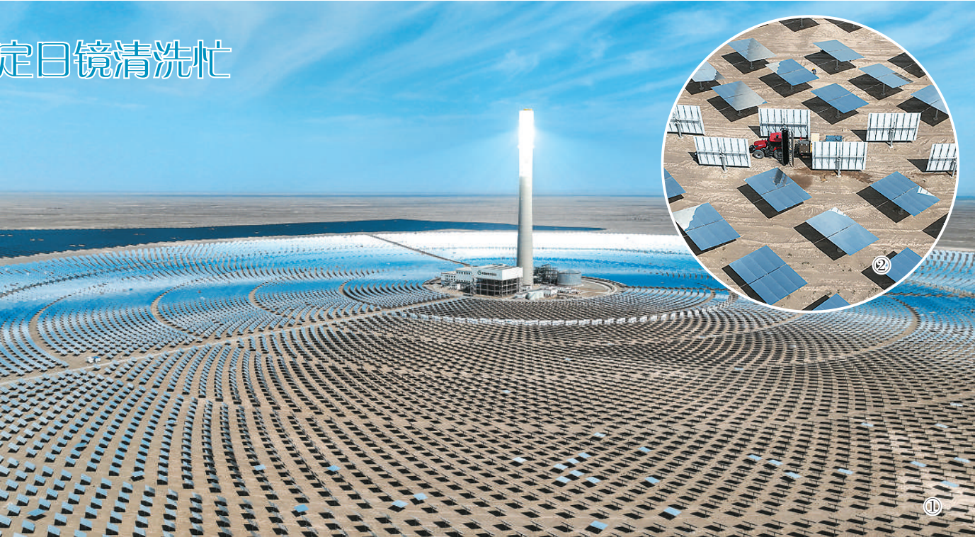
图①：在甘肃金塔多能互补基地“10万千瓦光热+60万千瓦光伏”项目现场，25594面光热定日镜如同银色“向日葵”环绕着247米高的吸热塔。
