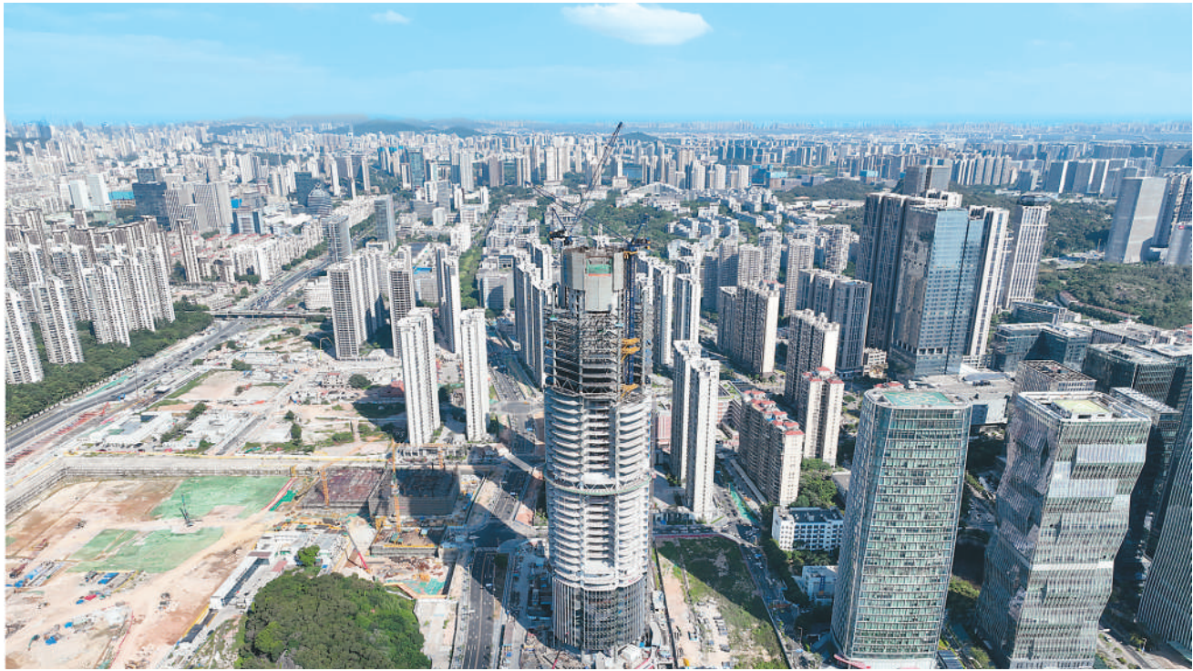
近日，由中建八局华南公司承建的厦门国际银行新总部大厦项目主体结构顺利封顶。该项目位于福建省厦门市两岸金融中心何厝片区，总建筑面积约11.55万平方米，建筑高度约210米，建成后将成为集总部办公、城市客厅等多种功能于一体的集团总部大厦，更好服务海峡两岸融合发展示范区建设。图为项目建设场景。 邓 讷摄
