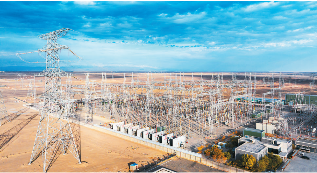
新疆是中国西电东送的重要送端，多条“疆电外送”通道把电量从新疆源源不断输送到中东部地区，有效服务西部大开发，促进新疆转化资源优势，打造全国重要的新能源基地。自2010年疆电外送工程实施以来，新疆外送电量累计超9000亿千瓦时，送电范围覆盖22个省份。 图为哈密南—郑州±800千伏特高压直流输电工程的天山换流站。
