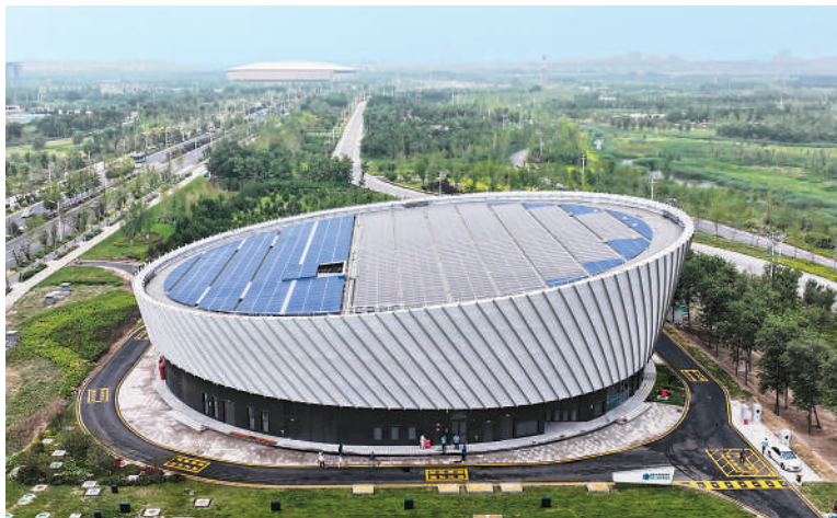
日前,雄安新区绿色建造示范工程——复兴220千伏变电站投运。该变电站是雄安新区首个全生命周期“近零碳”变电站、首个圆形钢结构变电站,变电容量360兆伏安,是雄安新区220千伏分区环网重要枢纽变电站,将担负起启动区总部聚集核心区域供电任务。图为复兴220千伏变电站。
