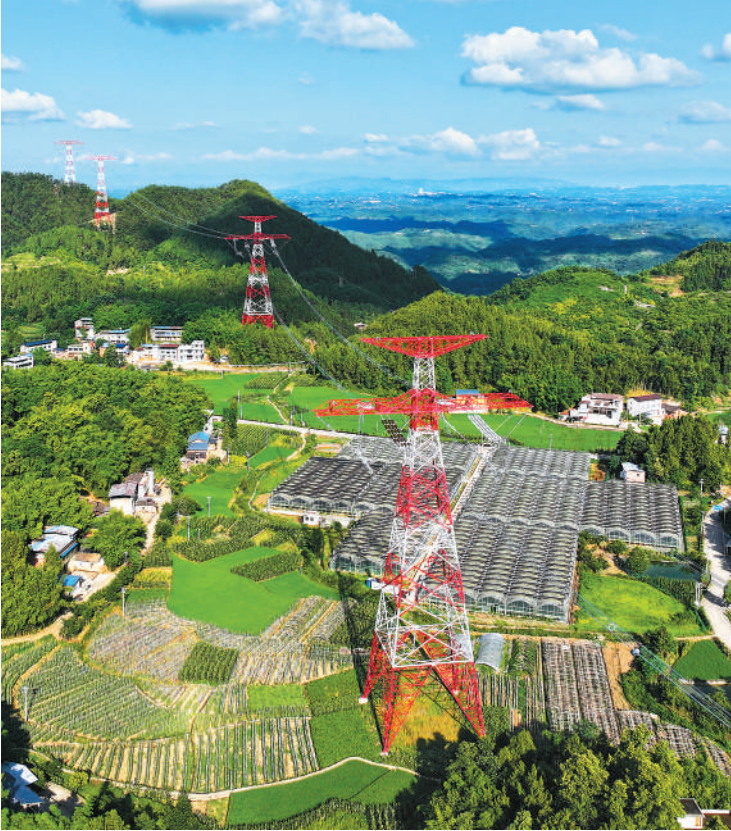
近日，金沙江上游—湖北±800千伏特高压直流输电工程（重庆段）跨越长江的导线、地线全部牵引到位，标志着该工程重庆段全线贯通。
