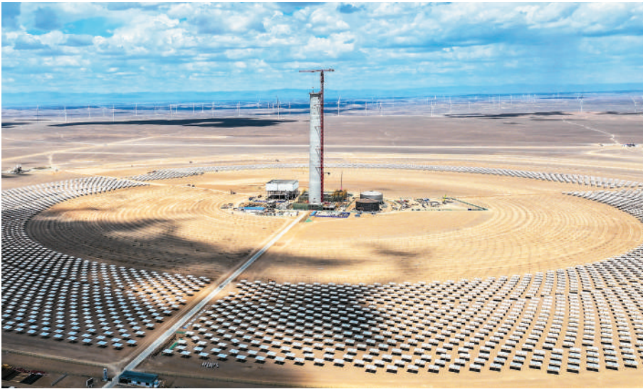
位于新疆维吾尔自治区哈密市的中能建哈密“光(热)储”1500MW基地项目建设正有序推进。该项目按照“光热+光伏”一体化模式开发，项目并网后，每年可提供绿电约28.92亿千瓦时，相当于节约标煤86.8万吨，减少二氧化碳排放225.6万吨。图为项目现场的定日镜和吸热塔。 钟卫亮摄（人民图片）
