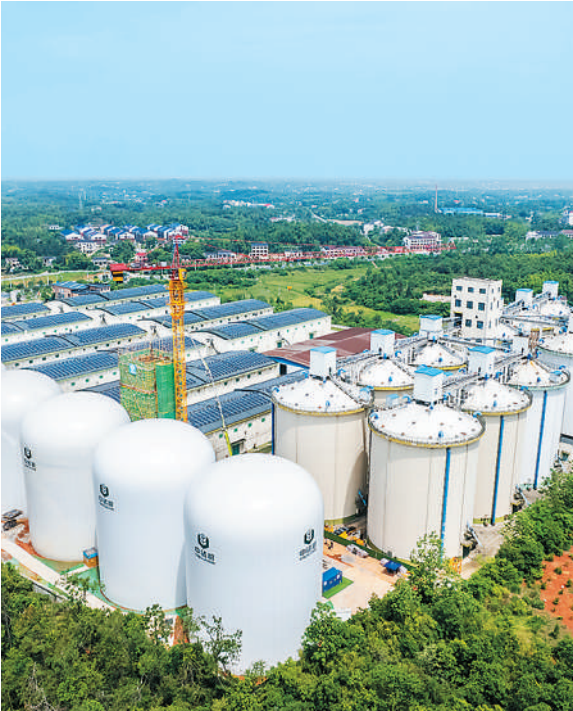
在中储粮长沙直属库拍摄的气膜粮仓建设施工现场。
