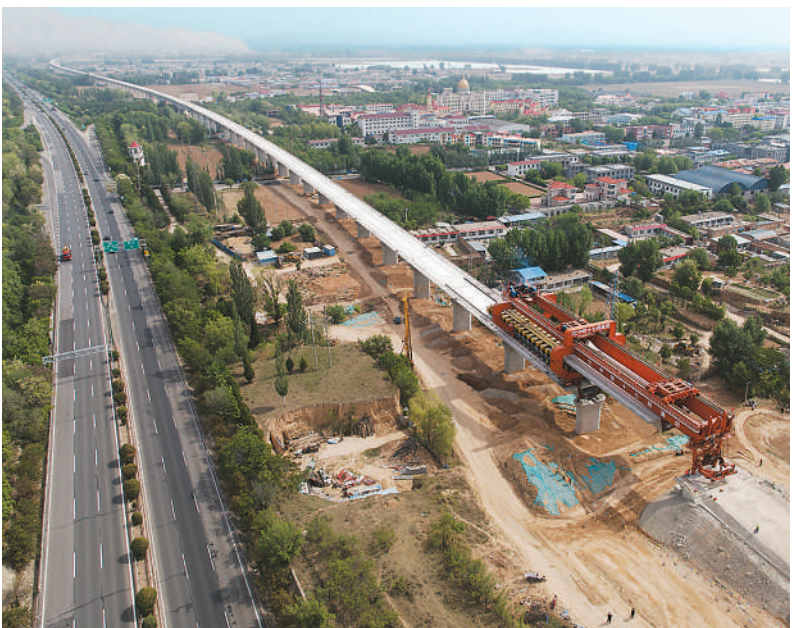
5月15日，随着最后一片长32米、重约697吨的箱梁完成架设，位于山西省忻州市境内的雄忻高铁最长桥梁五台山机场特大桥箱梁架设圆满完成，这是雄忻高铁全线首个完成箱梁架设的特大桥。图为架桥机在进行箱梁架设作业。 张 炯摄（人民视觉）
