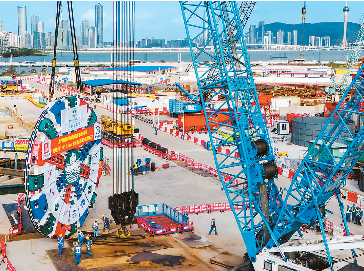
“澳氹1号”盾构机近日在澳门氹仔顺利下井组装，将助力澳门轻轨东线南段跨海段隧道项目建设。图为工人在指挥“澳氹1号”盾构机刀盘下井组装。 邱新生摄（人民视觉）
