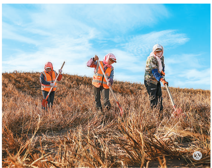
图②：2024年11月21日，甘肃省酒泉市金塔至大墩间公路沿线连绵起伏的沙丘上，工人们正在用稻草扎设草方格沙障。
