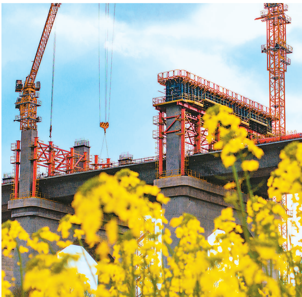
正在建设中的池州长江公铁大桥连接安徽省池州市贵池区和铜陵市枞阳县，按照“公路+城际铁路+城市轨道交通”合并过江的标准建设。项目对加强建设皖江区域基础设施、推进长三角一体化发展战略等具有重要意义。图为近日拍摄的池州长江公铁大桥贵池区建设现场。 储成胜摄(人民视觉)
