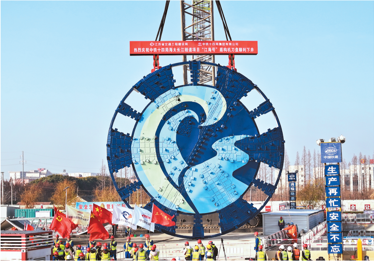
江苏省海太长江隧道是《长江干线过江通道布局规划（2020—2035年）》中明确的“十四五”重点推进的过江通道项目，是目前国内距离最长、断面最大的水下盾构隧道，堪称“万里长江第一隧”。图为1月22日江苏省南通市，海太长江隧道项目“江海号”盾构机刀盘下井现场。
