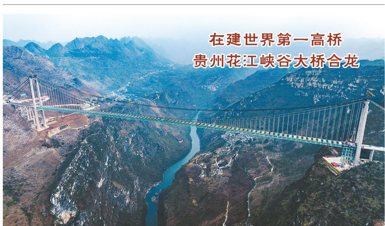
1月17日，在建世界第一高桥——贵州六安高速公路花江峡谷大桥成功合龙，为今年通车运营打下坚实基础。据介绍，大桥为钢桁梁悬索桥，全长2890米，其中主桥跨径1420米，桥面至水面高度625米，建成后将成为新的世界第一高桥、世界第一山区跨径桥梁。
