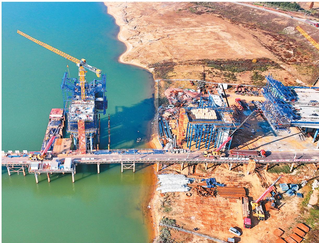
江西省南昌市南昌县昌南大桥横跨赣江,是G320南昌县向塘至新建区西山段公路新建工程的重要组成部分,也是南昌推进“十桥同架”重点项目之一。该工程建成后,将有效分流过境货运车辆,缓解市区交通压力、带动沿线区域经济发展。图为近日,工人在加紧推进桥梁承台和引桥建设。朱海鹏摄(人民视觉)
