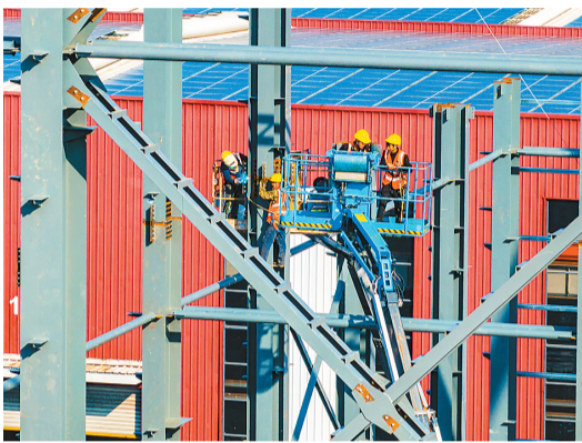
安徽省芜湖市繁昌区持续优化营商环境，精准落实各项惠企政策措施，助推经济高质量发展。图为繁昌经济开发区内，工人在招商引资项目建设工地上施工作业。
