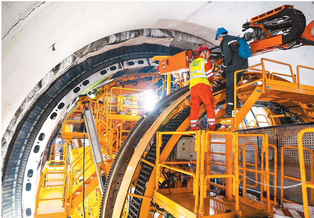
1月5日，引江补汉工程首台双护盾硬岩掘进机“江汉平安号”在湖北省宜昌市夷陵区顺利掘进始发。引江补汉工程是南水北调后续工程首个开工建设的重大项目，也是加快构建国家水网主骨架和大动脉的标志性工程。“江汉平安号”双护盾硬岩掘进机开挖直径11.93米，总长约180米，工作时可实现掘进作业和管片安装同步进行。图为掘进施工现场。 新华社记者 肖艺九摄
