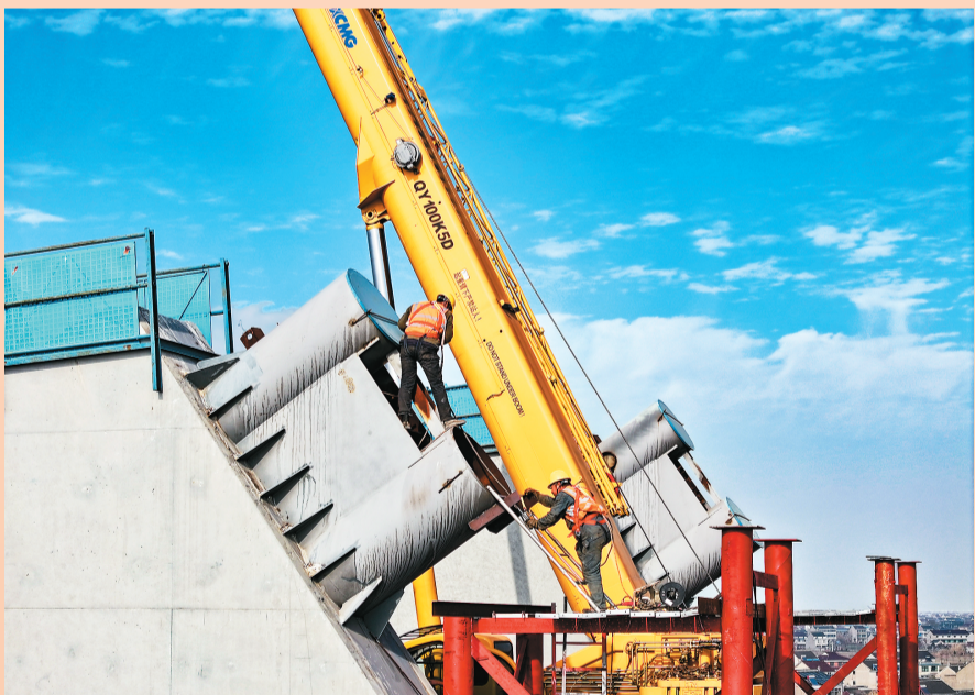
▲ 1月1日，建设人员在位于江苏省泰兴市分界镇境内的沪渝蓉高铁泰州段跨如泰运河连续梁施工现场进行拱安装施工作业。 顾继红摄（人民图片）
