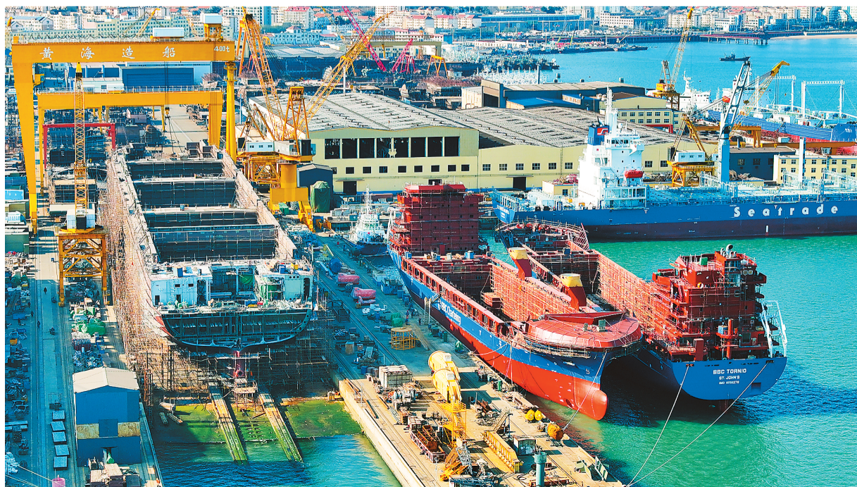
1月2日,山东省荣成市石岛管理区石岛湾畔一家造船企业船坞内,多艘大型船舶正在加紧建造,呈现一派繁忙景象。近年来,荣成市石岛管理区加大技术创新和自主研发力度,目前已形成以船舶海工制造为龙头、配套产业和技术研发同步发展的船舶产业集群。 杨志礼摄(人民视觉)
