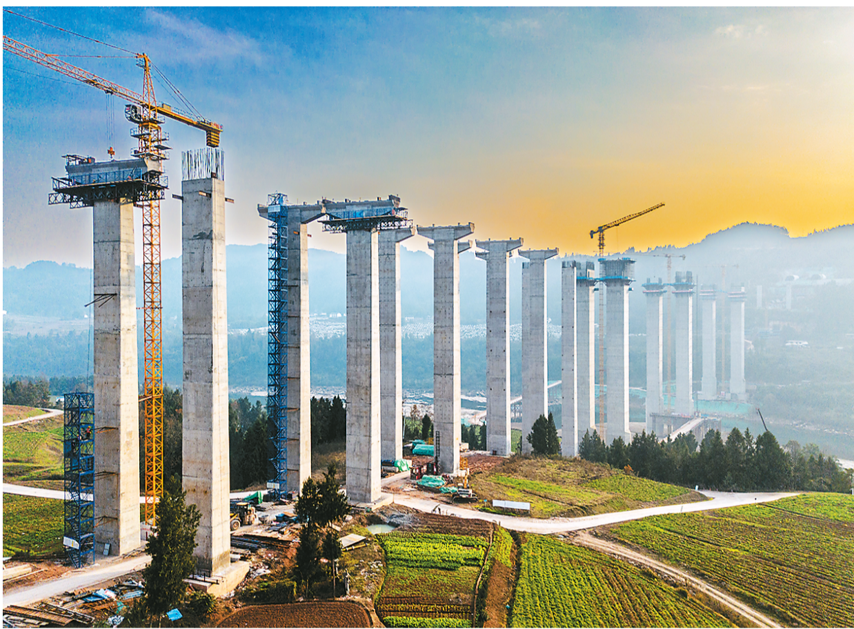
1月2日,四川省巴中市通江县境内,镇广高速广纳通江河特大桥项目正在加快建设。镇广高速公路起于陕西省镇巴县,经四川省巴中市、达州市至广安市,向南可通至重庆,是成渝地区双城经济圈建设的重要通道项目之一。据了解,镇广高速将川陕革命根据地红军烈士陵园、博物馆等红色旅游景点串联起来,是全国首条红色主题高速公路。 程 聪摄(人民视觉)
