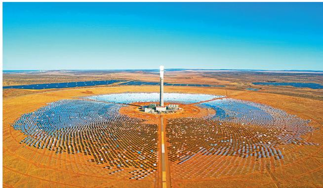
图为南非红石100兆瓦塔式熔盐光热电站项目。
