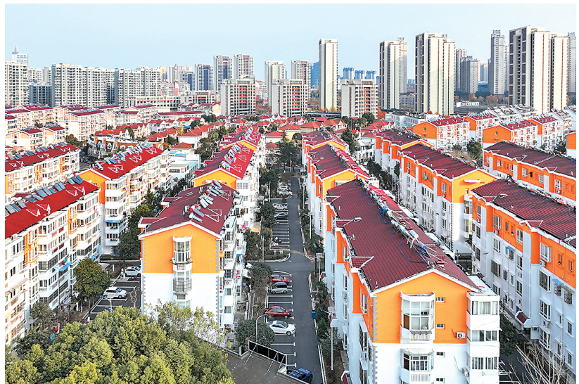
安徽省六安市金安区望城街道东苑社区东苑小区，经外墙维修、管网改造、绿化提升等项目改造后旧貌换新颜，实现了“忧居”到“宜居”的转变。田凯平摄（人民视觉）
