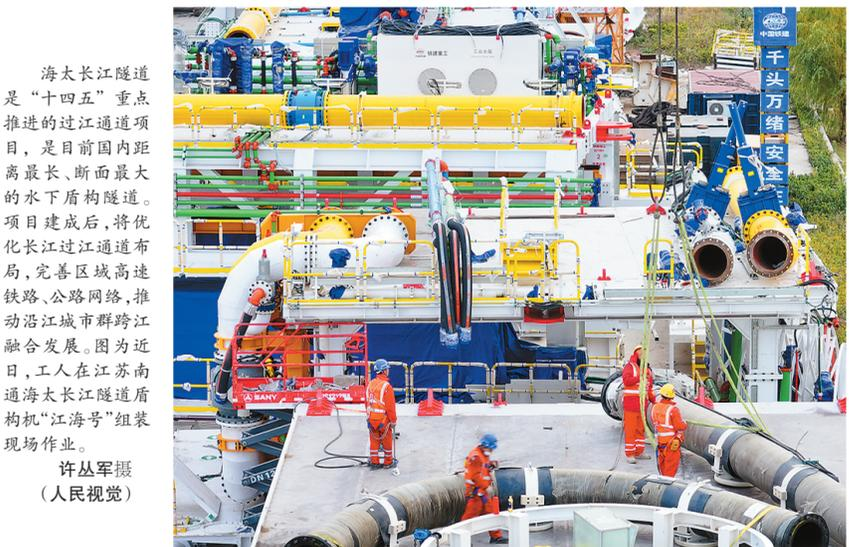
海大长江隧道是“十四五”重点推进的过江通道项目，是目前国内距离最长、断面最大的水下盾构隧道。项目建成后，将优化长江过江通道布局，完善区域高速铁路、公路网络，推动沿江城市群跨江融合发展。图为近日，工人在江苏南通海大长江隧道盾构机“江海号”总装现场作业。
