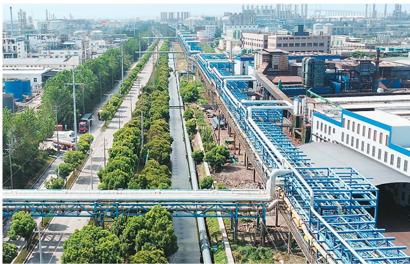
在中国化工新材料(嘉兴)园区，空中架起的管廊将污水送到处置线进行处理。
