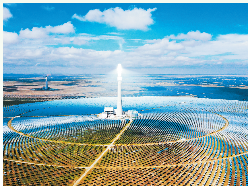
光伏治沙是共和县多种治沙措施之一。图为共和县塔拉滩光伏基地已投产的50MW塔盐塔式光热电站。
