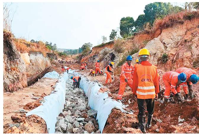
▲ 中铁二十局抢险队在垮塌路段进行地下导流沟施工。 强星星摄
