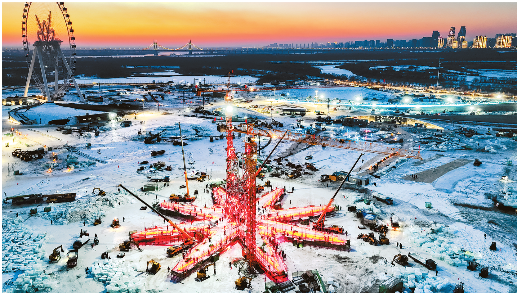
日前，位于黑龙江省哈尔滨市松北区的第二十六届哈尔滨冰雪大世界正紧张施工，建设者正在现场繁忙作业。
