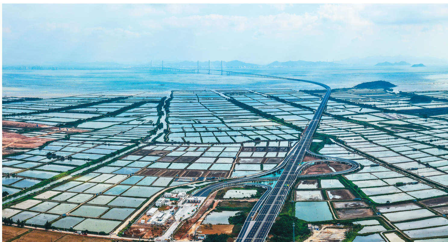
近日，黄茅海跨海通道台山段已全部建设完毕，静待通车。黄茅海跨海通道全长约三十一公里，建成通车后将与港珠澳大桥、深中通道、南沙大桥、虎门大桥共同组成粤港澳大湾区跨海跨江通道群。图为黄茅海跨海通道台山段的赤溪东互通立交。
