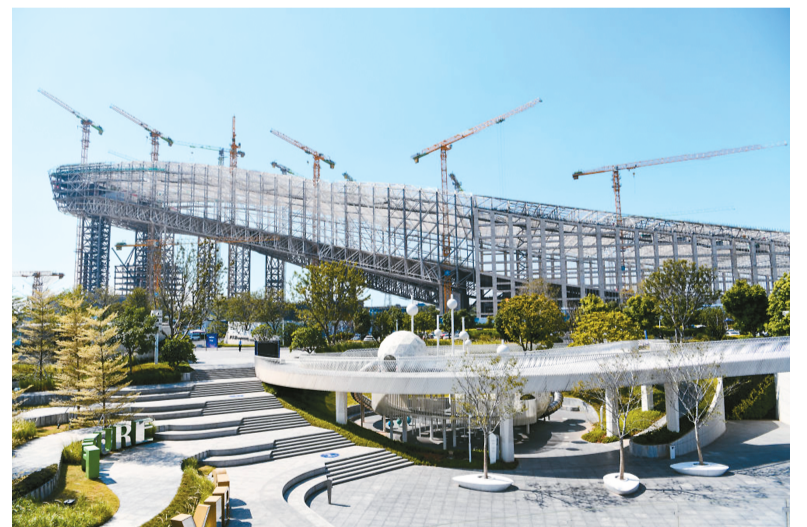
▲正在建设中的深圳前海华发冰雪世界。新华社记者 梁旭摄
