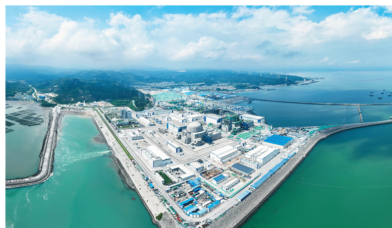
9月27日拍摄的建设中的漳州核电站。
