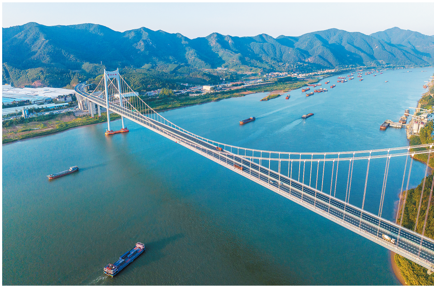
近日,在位于广东省云浮市的珠江上游西江肇云大桥,江面上装运各类货物的船舶来回穿梭,呈现一片繁忙景象。广东近年来依托区位优势,推进内河航运高质量发展,综合航运能力显著增强,运输服务质量持续提升。何华文摄(人民视觉)
