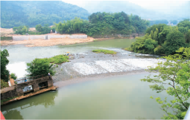
世界灌溉工程遗产姜席堰引水枢纽，由姜堰、席堰及进水闸、冲砂闸组成。姜、席二堰由沙洲连接，共同构成一个曲尺形的拦河工程。2019年，洪水来袭，将江心沙洲中部冲开。在新编制的《姜席堰世界灌溉工程遗产保护与利用总体规划》中，已将沙洲列入重点保护对象。图为龙游姜席堰渠首工程枢纽中的席堰及冲砂闸。
