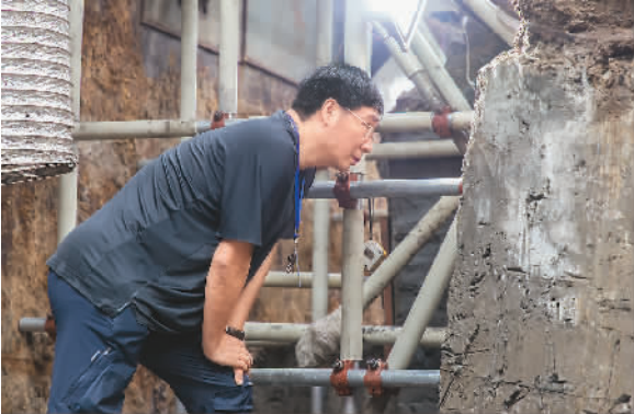
这张照片拍摄于2020年4月26日。考古队员拍到了他们领队崔勇做现场评估的场景。在沉船的外围，已经进展到发掘外侧反斜面位置，此时支护要预防船向下和向外的移位。支架太疏带来风险，太密则会影响发掘。邓嘉韶摄
