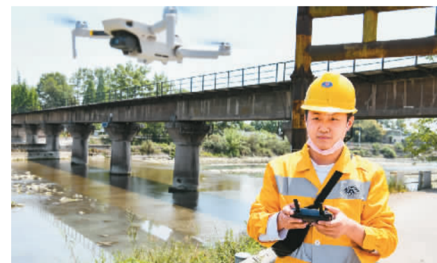
入汛以来，中国铁路成都局集团公司成都工务段利用全站仪、无人机等开展隐患排查，确保汛期铁路安全。图为技术人员近日操作无人机在成都市蒲阳河1号桥，准备进行铁路桥的隐患排查。新华社发
