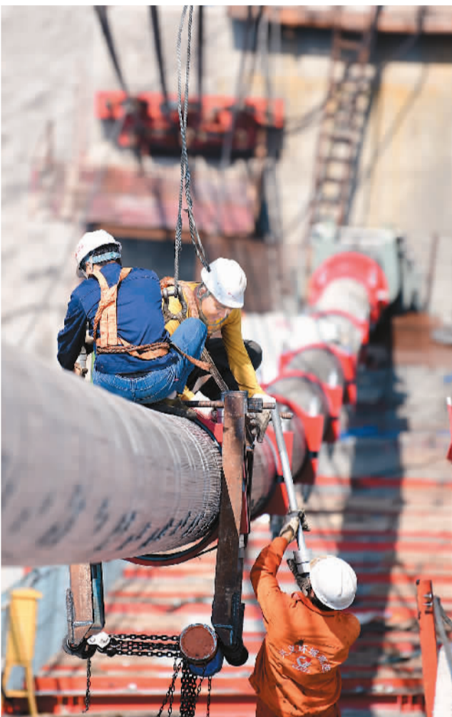
▼ 在贵州省黔东南苗族侗族自治州兴义环高峰林特大桥，工人在加紧施工。 尚宇杰摄（人民视觉）
