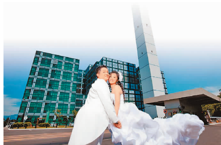
新北市八里焚化厂外观雄伟壮丽，成为新人拍摄婚纱照的新景点。
