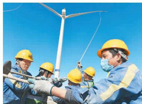
5月1日,在青海共和的黄河水电公司风力发电项目建设现场,施工人员进行风力发电机组吊装作业。
