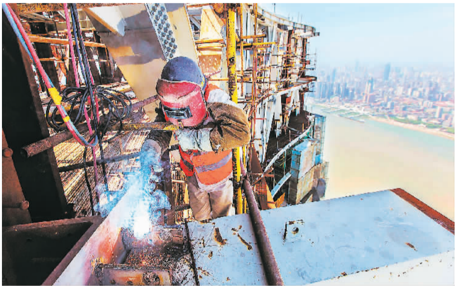
▲ 4月13日，在海拔475米高的武汉绿地中心98层楼施工现场，中建三局焊工朱时运正在进行外框型钢柱焊接。项目在抓好所有人员防疫的前提下，争分夺秒抢回前期失去的施工时间。湖北日报记者 梅 涛摄
