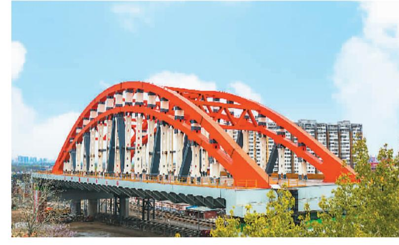
4月9日,今年防疫期间北京首批复工的重点铁路工程,丰台特大桥主跨钢箱拱桥顺利推至设计桥位。该拱桥为北京铁路枢纽丰台站控制性工程,桥跨112米,为全国首座六线简支钢箱拱桥。
