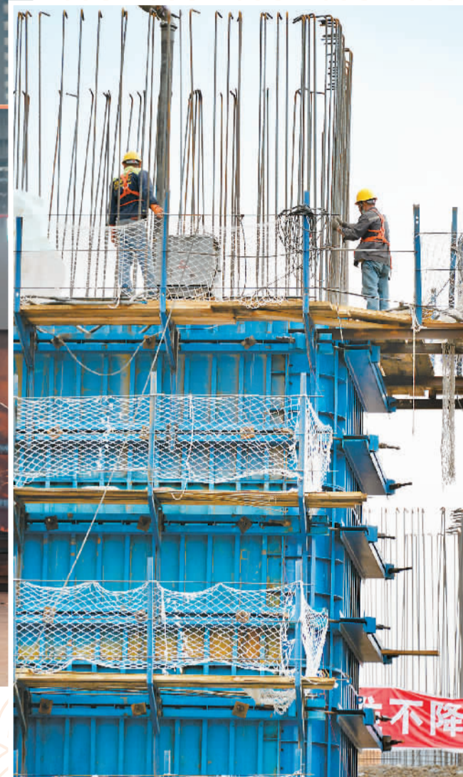
▼ 3月26日，工人正抓紧浇筑鄂州高铁湖北兴山段古夫特大桥桥墩，把耽误的时间赶回来。 吴君 邹远景摄影报道（人民视觉）
