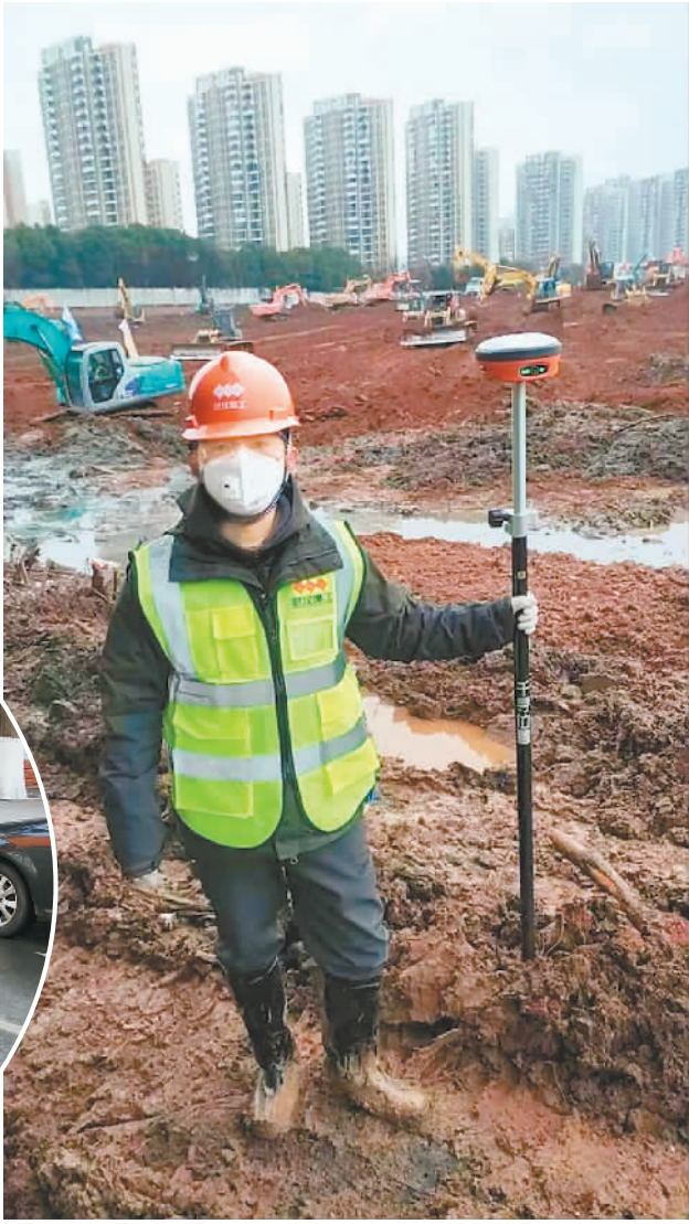
▲ 孙见新在武汉火神山医院建设现场进行测量工作。千寻位置供图
