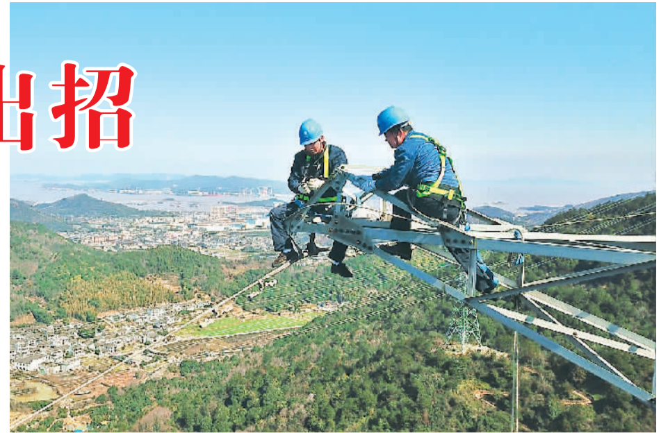
近来，国网舟山供电公司持续开展线路特巡保供电工作，全力助力舟山企业全面复工复产。图为浙江舟山电力工人在定海小沙区域的220千伏朗顶线铁塔上更换绝缘子。 姚 峰摄（人民视觉）
