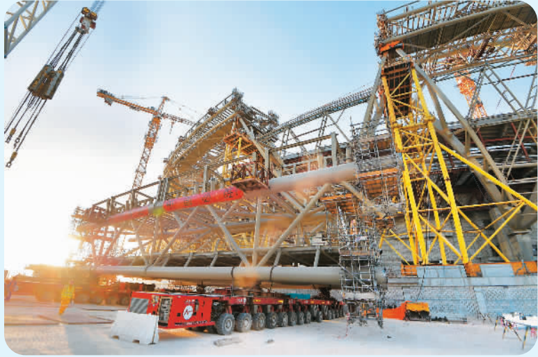
2月16日，在卡塔尔多哈，张贴着“武汉加油！中国必胜！”横幅的合龙段压环吊装升空，并迅速就位合龙，标志着中国铁建国际集团（中铁建）承建的卡塔尔2022年世界杯足球赛主体育场项目主体钢结构施工完成，“马鞍形”外观成型。 尼 库摄（新华社发）
