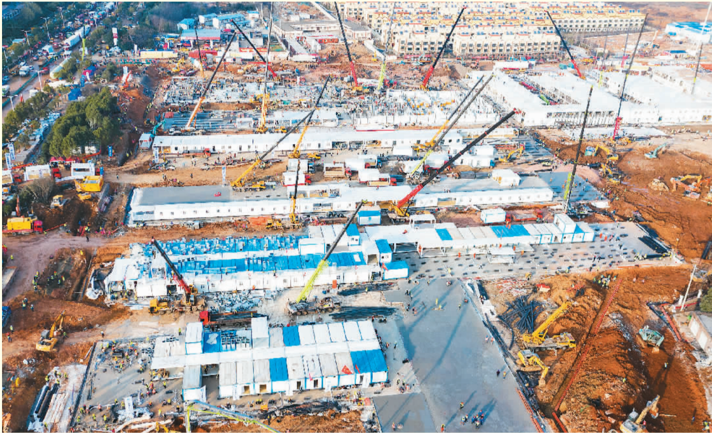
图为1月30日拍摄的武汉火神山医院建设工地。
