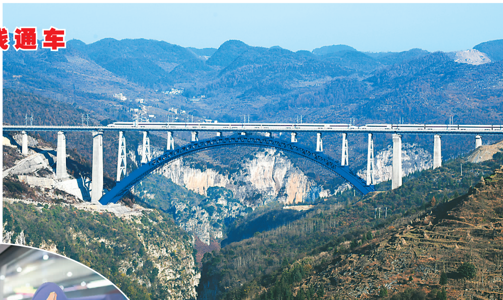
图为一列动车组列车从成贵高铁西溪河大桥上驶过。
