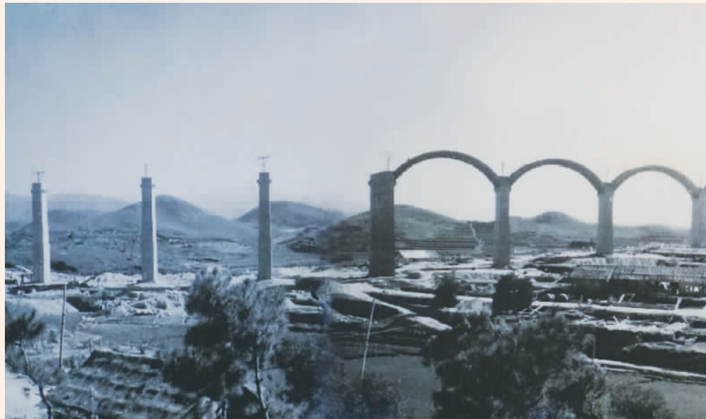
▲ 为节省材料、集中劳力，向东渠在建设过程中采取分段砌拱。
