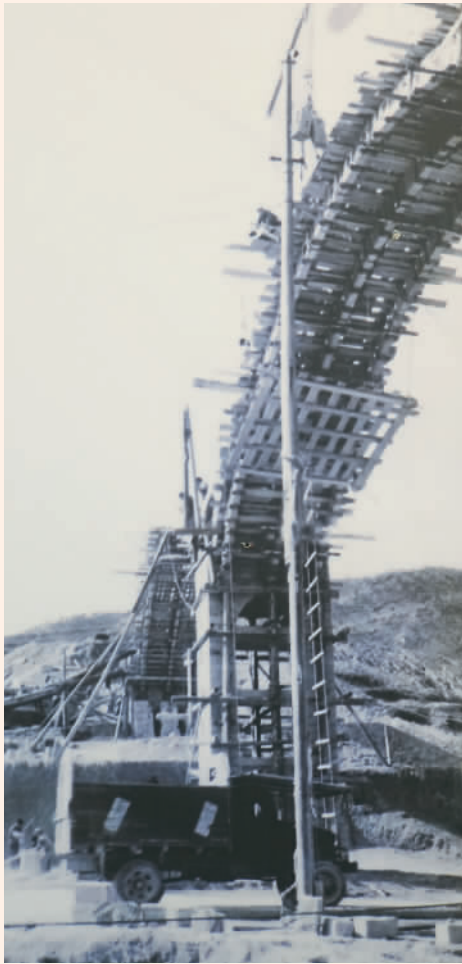
▲ 攻坚克难，设计新式拱架吊装土绞车。
