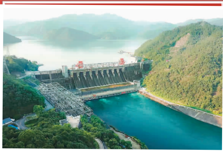
▼新安江水电站是新中国自行设计、自主建设的第一座大型水电站，为三峡工程建设积累了经验，培养了人才。 本报资料
