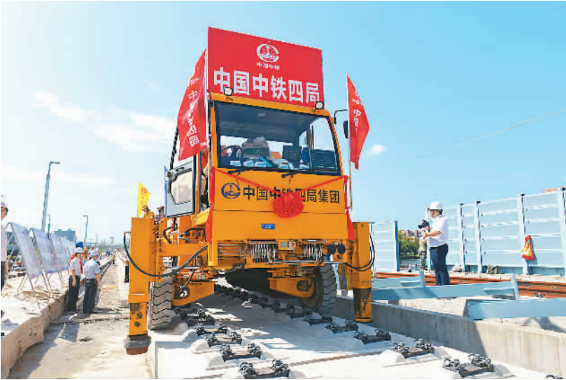
珠三角城际铁路新塘经白云机场至广州北站（简称新白广）线近日正式开始铺轨。图为中铁四局在新白广城际二标铺下第一组500米长轨。
