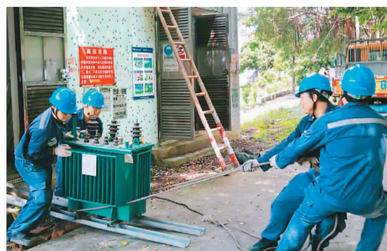
近日，广东省江门市天气持续高温炎热，用电负荷连创新高。南方电网广东江门供电局统筹安排系统运行、重点工程建设、安全生产监督等工作，确保客户有序用电。图为供电局职工冒着高温进行变压器施工。 沈皓羿、梁嘉淇摄影报道
