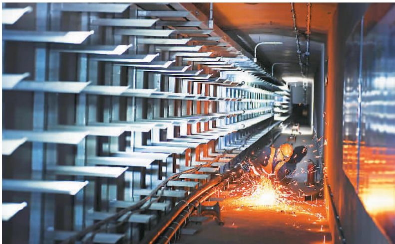
今年8月底，全长约8公里的北京冬奥会延庆赛区管廊设备安装将基本完成，9月底完成调试。该管廊将成为冬奥会期间延庆赛区造雪用水、生活用水、电力、电信的通道，被称为赛区“生命线”。图为中铁一局建安公司施工现场。杨军摄
